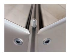
Vérifier la mise à niveau avec les vérins à vis puis replacer les verres.
